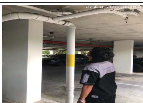
รูปที่ 4.7-1 การตรวจสอบการรั่วซึมที่ระบายน้ำ
